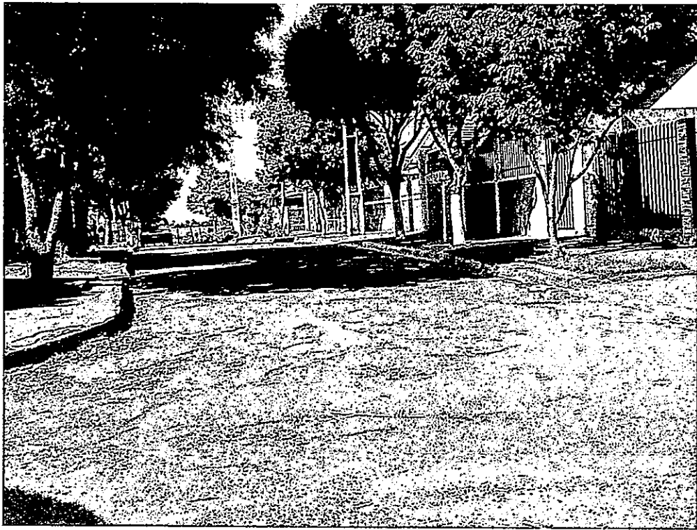
Rua Paranavaí - Pulínópolis - PR
