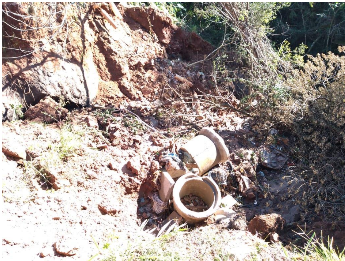
Córrego Arurão –Dissipador Galeria pluvial
