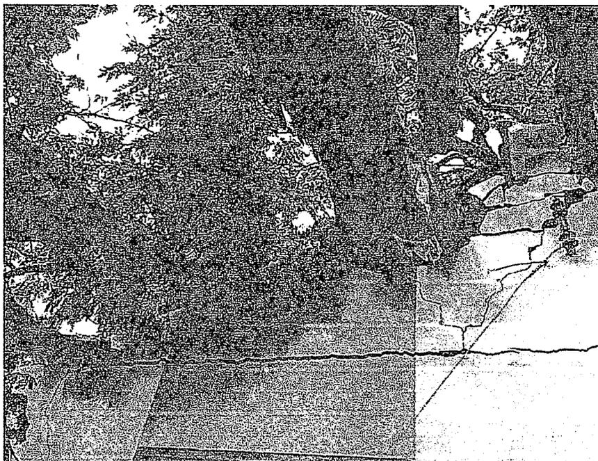
Figura 4 – Imagem aproximada dos danos no oitão e no lado esquerdo fissura por falta de junta de dilatação em ampliação já existente.
